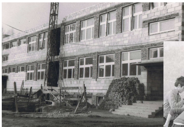
Nowy segment szkolny od strony boiska.
